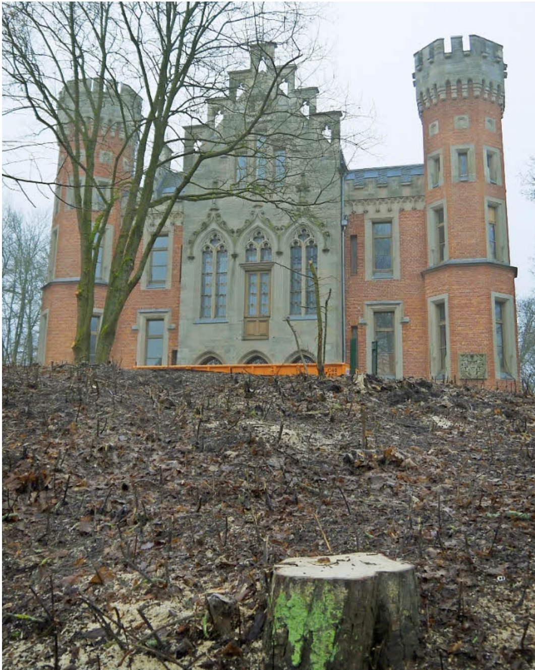
Die Böschung, die das Ketschendorfer Schloss umgibt, wurde ausgelichtet und winterfest gemacht. Der Zaun wurde dafür entfernt, soll aber demnächst ersetzt werden.
